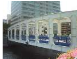
豊海橋（中央区） 日本初のフィーレンディール橋
